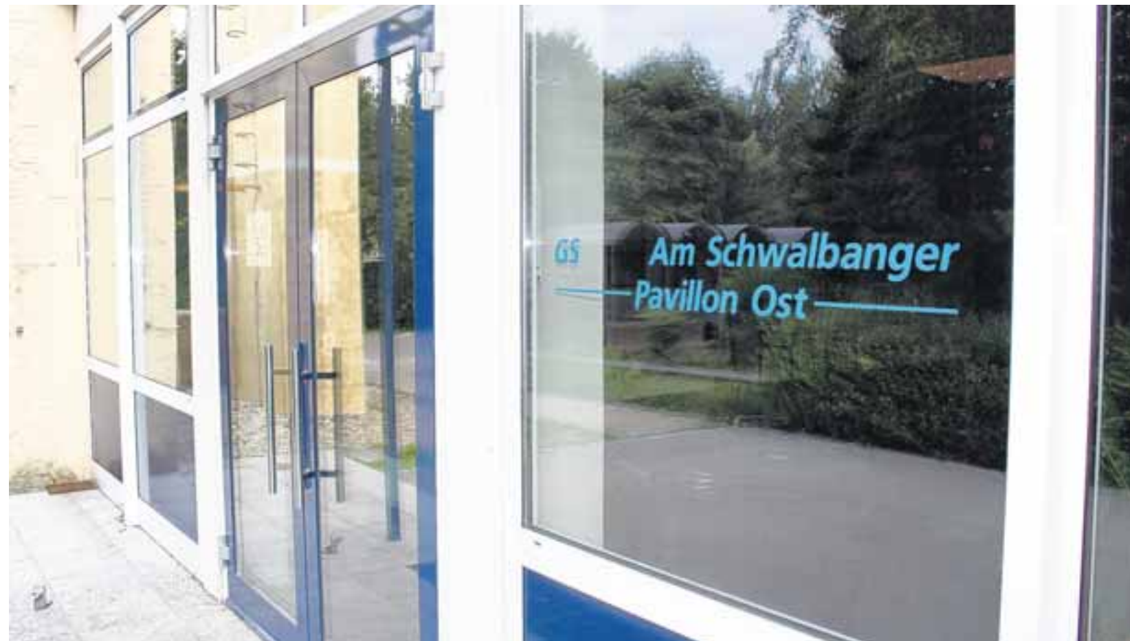
Wenn einer der beiden Pavillons an der Schwalbangerschule abgerissen wird, dann ist es wohl der im Osten. Fünf der sechs Architekturbüros sehen in ihren Lösungsvorschlägen nur einen Pavillon vor. Foto: Michael Böhm
